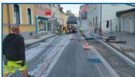
Wiener Straße mit neuer Asphaltdecke versehen Bericht Seite 8
