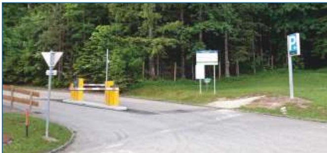
Die neue Schrankenanlage
