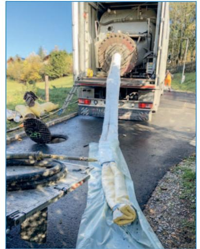
Auch der Schmutzwasser-Kanalstrang, über den ein Großteil des Abwassers vom Stadtkern Mariazell in Richtung Kläranlage fließt, war im Bereich Sandbühelweg bereits mehrfach sanierungsbedürftig. Hier fiel die Entscheidung aber nicht auf einen Kanal-Neubau in offener Bauweise, sondern auf eine grabungsfreie Sanierung mittels Inliner-Verfahren.
