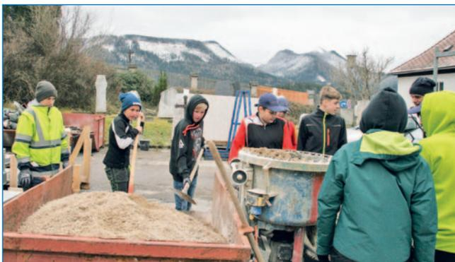
der Firma Hölblinger & Zefferer fertigten mit den Schüler\*innen die Schalungen für die vier Sockel und beim nächsten Termin wurde betoniert.
