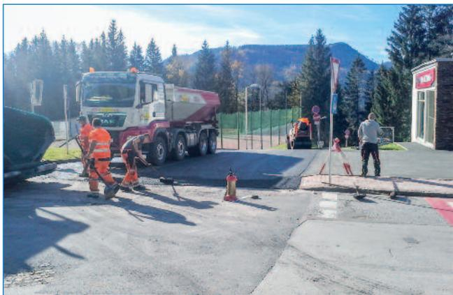
Der Sandbühelweg wird auch nach dem Wintereinbruch noch ordnungsgemäß fertiggestellt. In der letzte November- und ersten Dezemberwoche wurden diese Arbeiten durchgeführt. Dabei wurde auch die gesamte Wasserleitung erneuert sowie der Frostkoffer neu aufgebaut.
